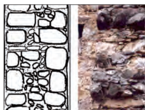
Fig. 3.1 – Pc: sezione a paramenti ben collegati o ad unico paramento (sezione piena)
