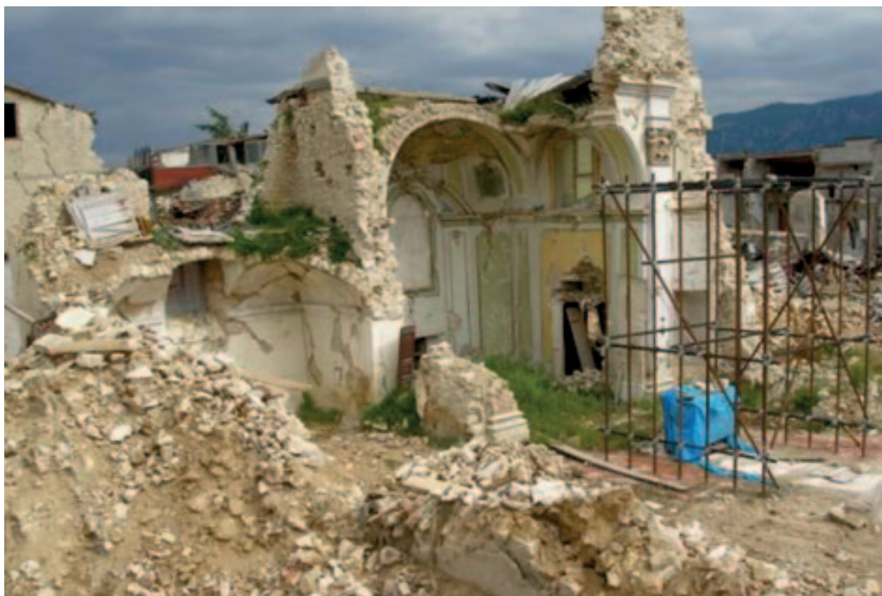
La chiesa dopo il sisma
