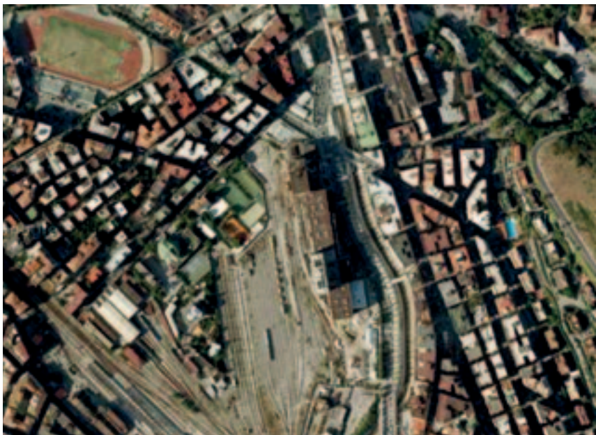
Vista satellitare del cantiere della Cittadella Giudiziaria
