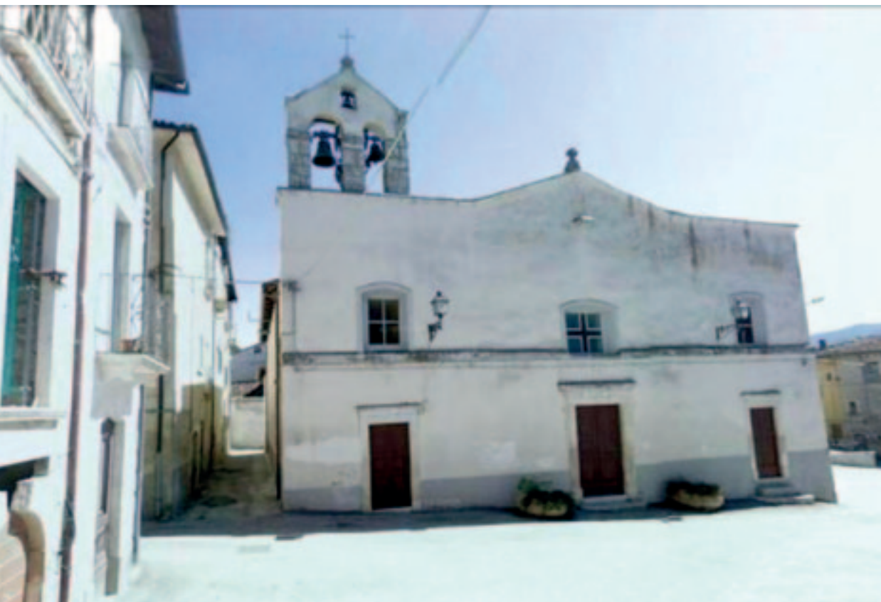
La chiesa prima del sisma
