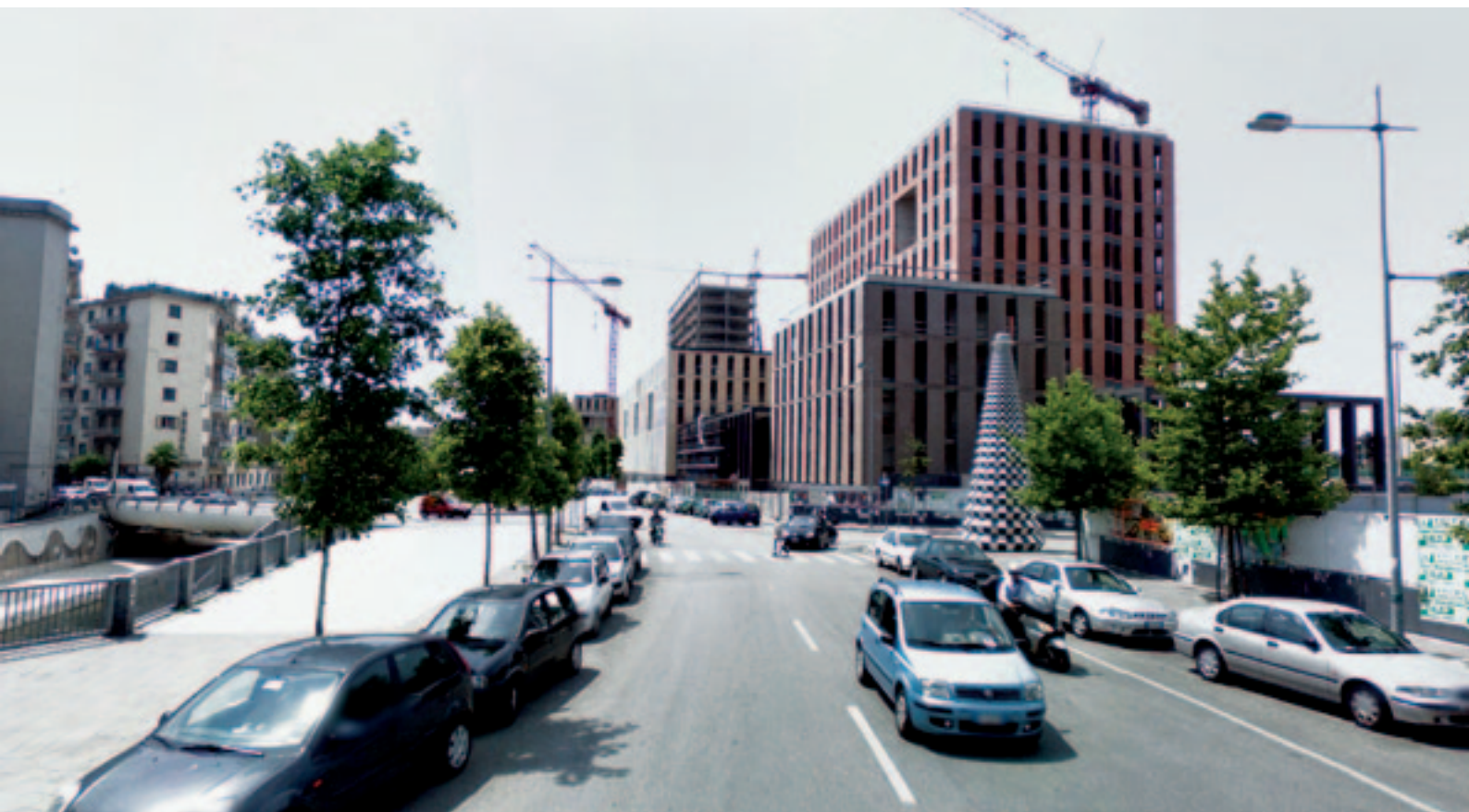
Il cantiere della Cittadella Giudiziaria
